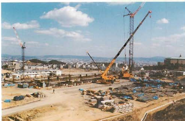
ただいま工事中
