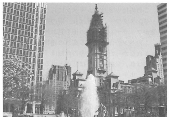
市庁舎とウィリアム・ベン・タワー
