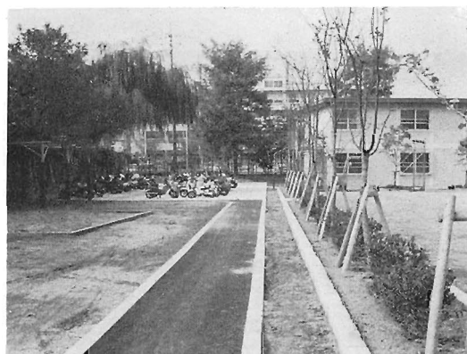
新設の単車専用置場
