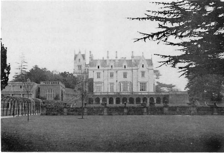
リリシャルホール・スポーツセンター庭園より撮す
